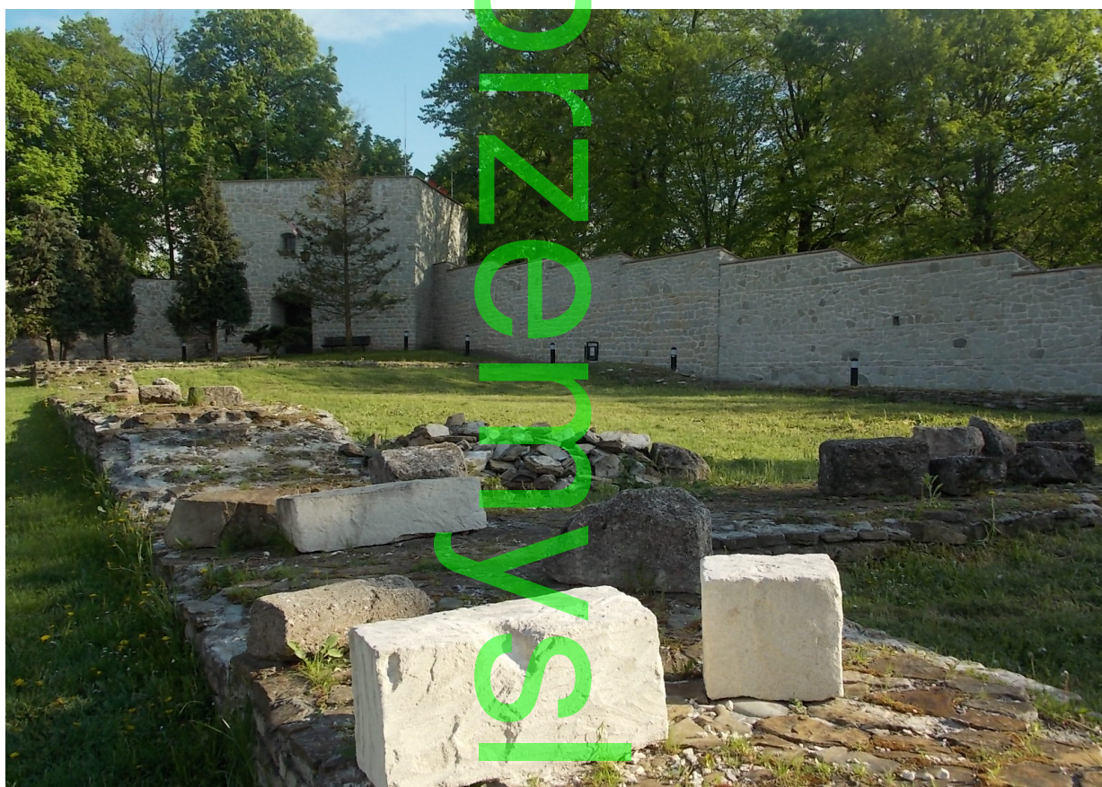
Fundamenty Rotundy na zamkowym dziedzińcu
